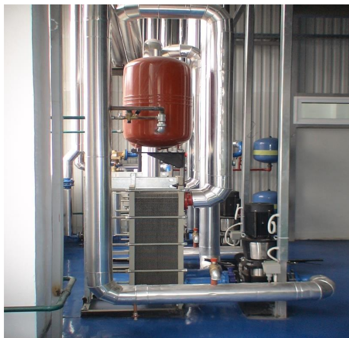
VEDERE DE ANSAMBLU PENTRU SCHIMBATOARELOR DE CALDURA CU PLACI
